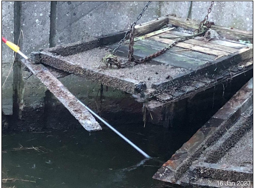
Billede 2: Den nuværende sluseports tilstand
