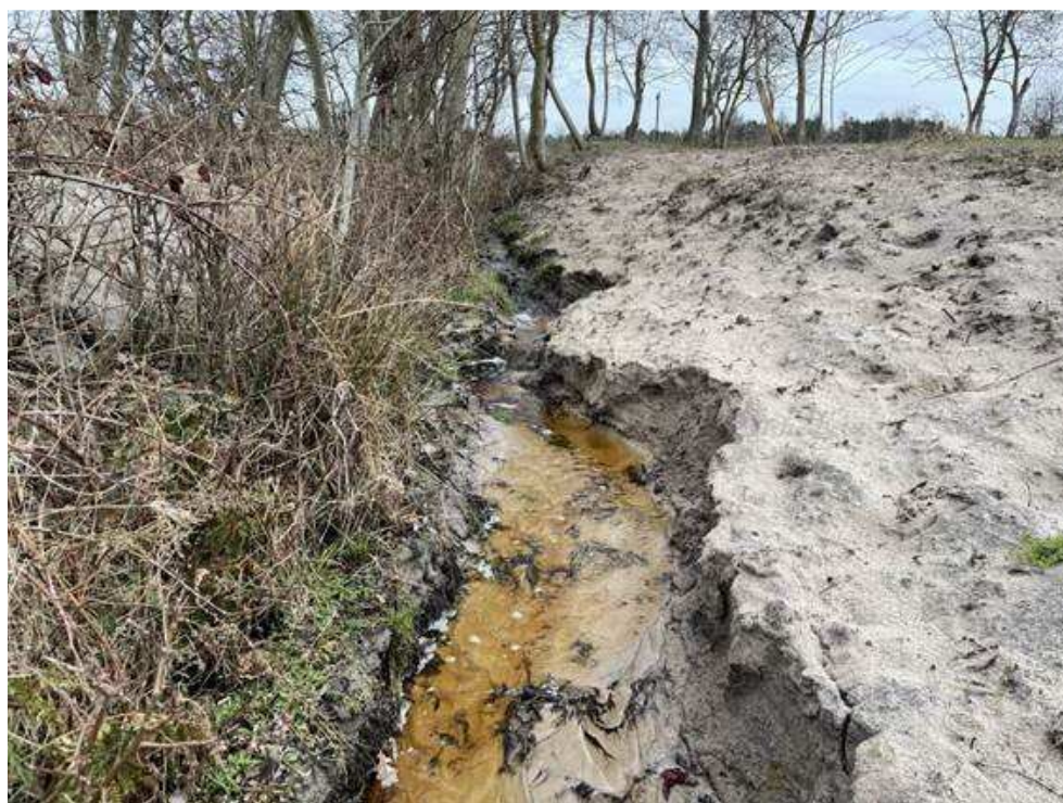
Figur 3. Grøften med afløbet fra den centrale del af Petersdalengen set opstrøms fra overkørslen ved Østre Ringkanal den 12. marts 2021.
