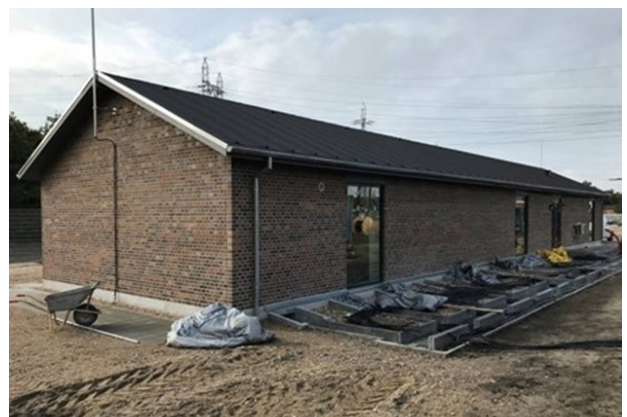
Figur 5. Eksempel på teknik- og mandskabsbygning.
