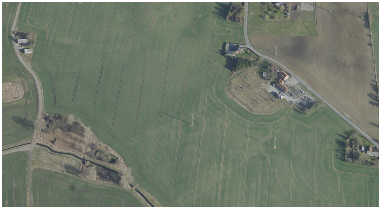
Figur 2. Lokalplanområdet set fra oven mod nord. Her kan bl.a. ses det eksisterende højspændingsanlæg, de omkringliggende boliger og marker.
