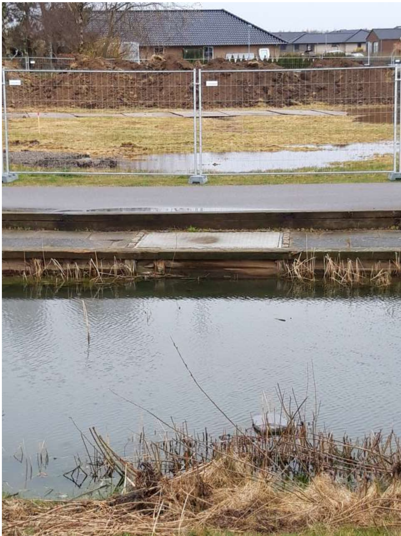
Billede 3 Overløb fra mose 4 til Forsyningens regnvandskloak
