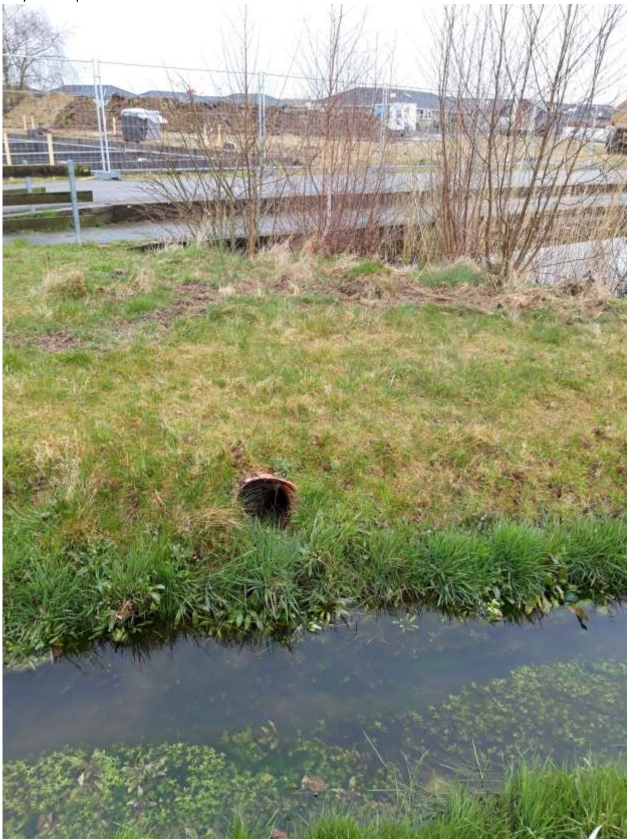
Billede 1 Rørlagte nødoverløb fra mose 4 til Vandløbet
