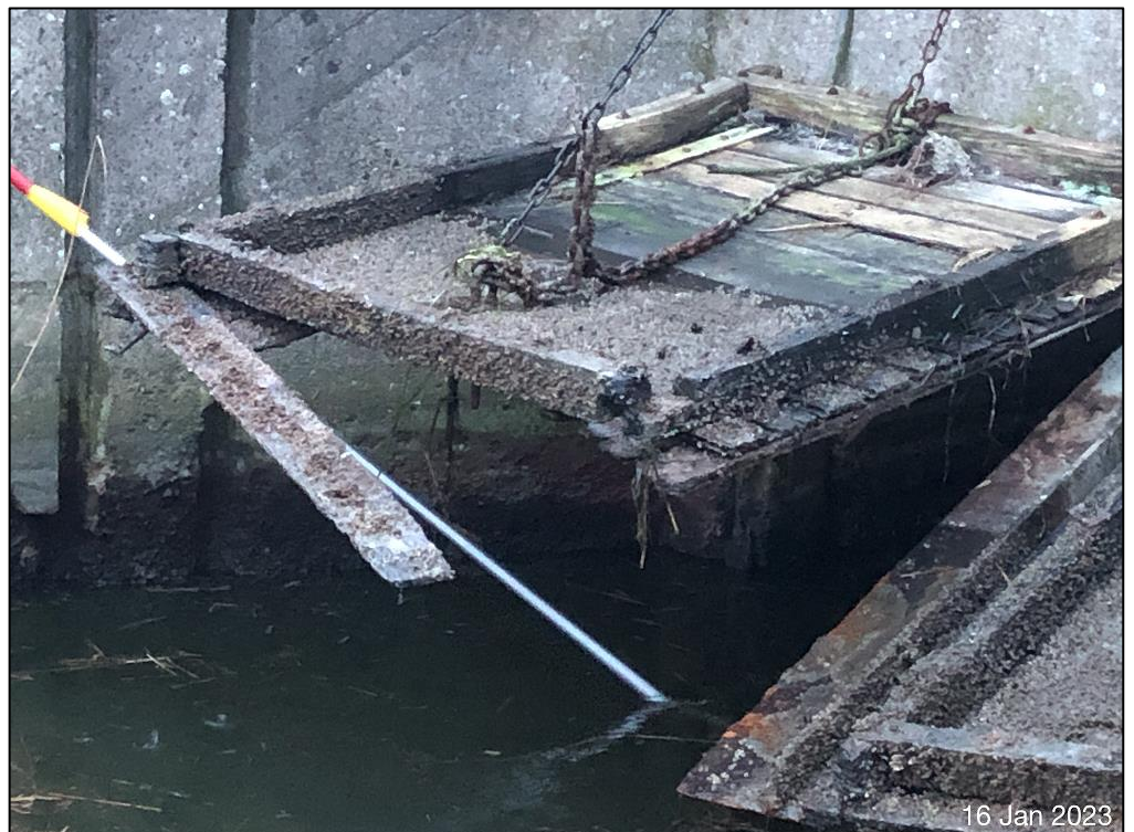
Billede 2: Den nuværende sluseports tilstand
