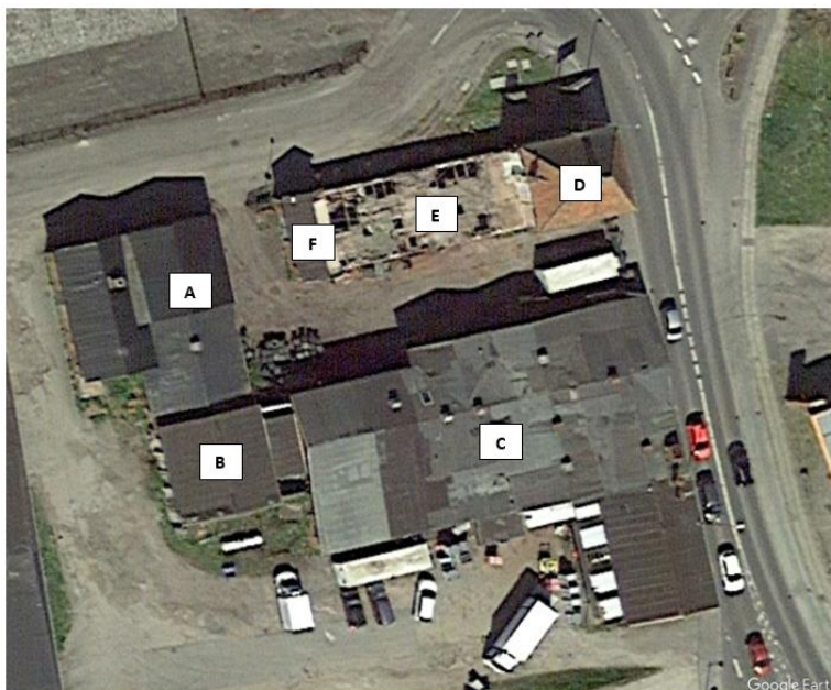
Figur 10-2: Oversigt over bygningsmassen på ejendommen Sydhavsvej 1 (det gamle slagteri) i Nykøbing Falster. Bogstaverne A til F betegner inddeling af bygninger.
