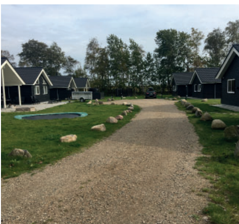
Gruppe af nye sommerhuse med tilhørende friareal
