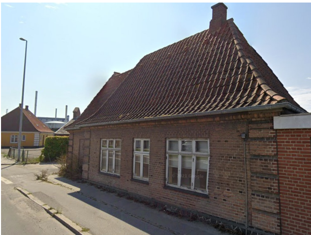
Betonværkets administrationsbygning (1928), sikres med bevarende bestemmelser og indgår i erhvervsbyggefeltet.
