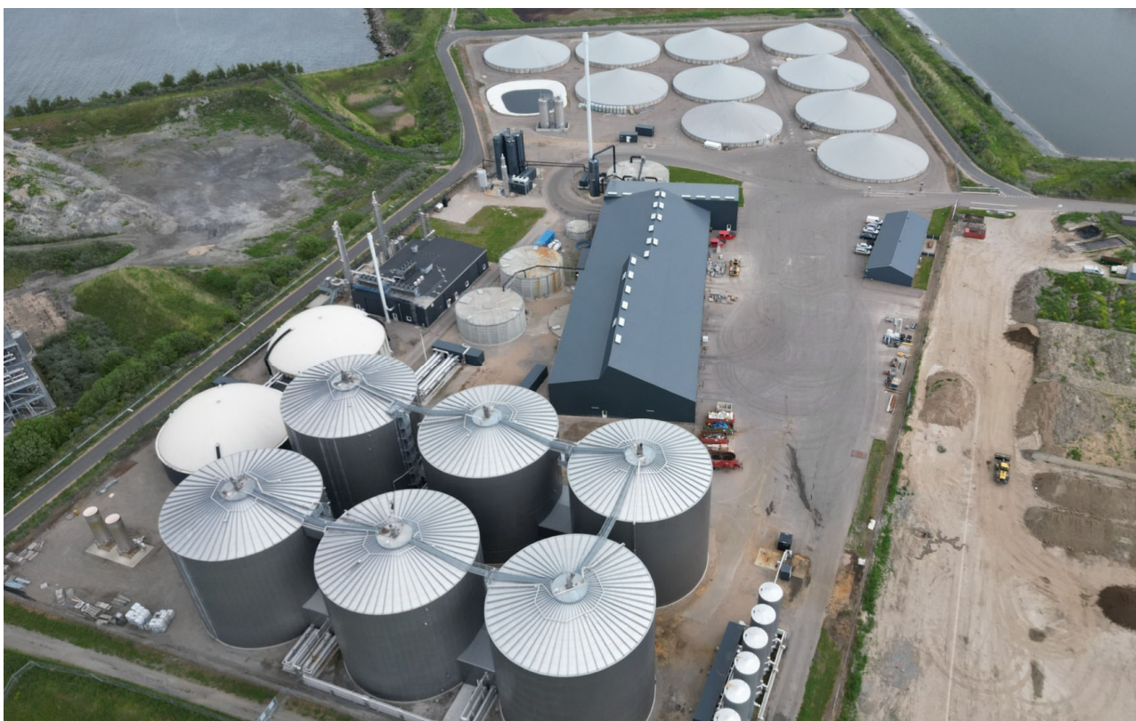
Luftfoto af tilsvarende størrelse biogasanlæg som indholdet i denne lokalplan. Eksemplet er fra Kalundborg
