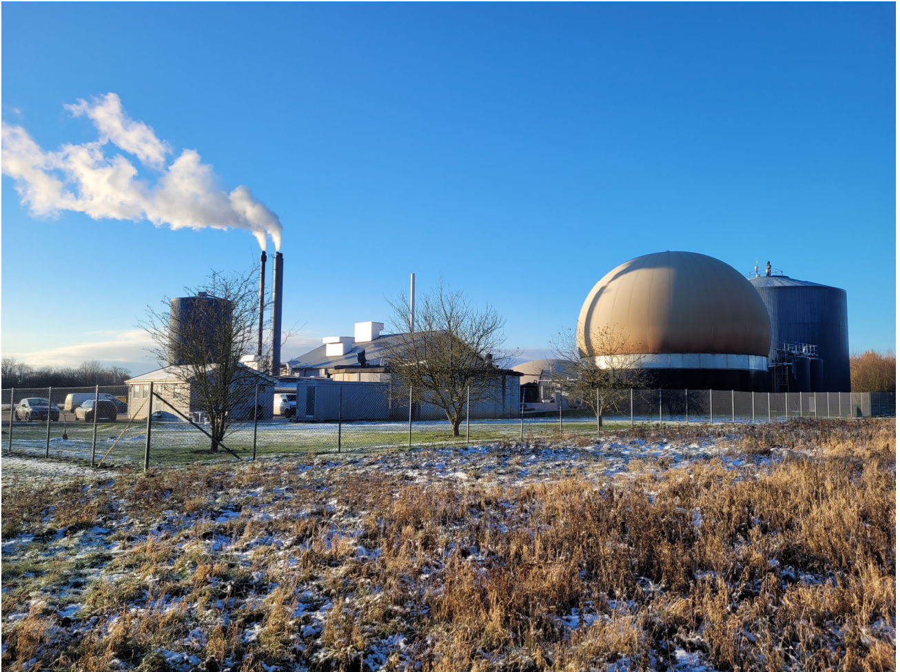
Det eksisterende biogasanlæg i Kettinge
