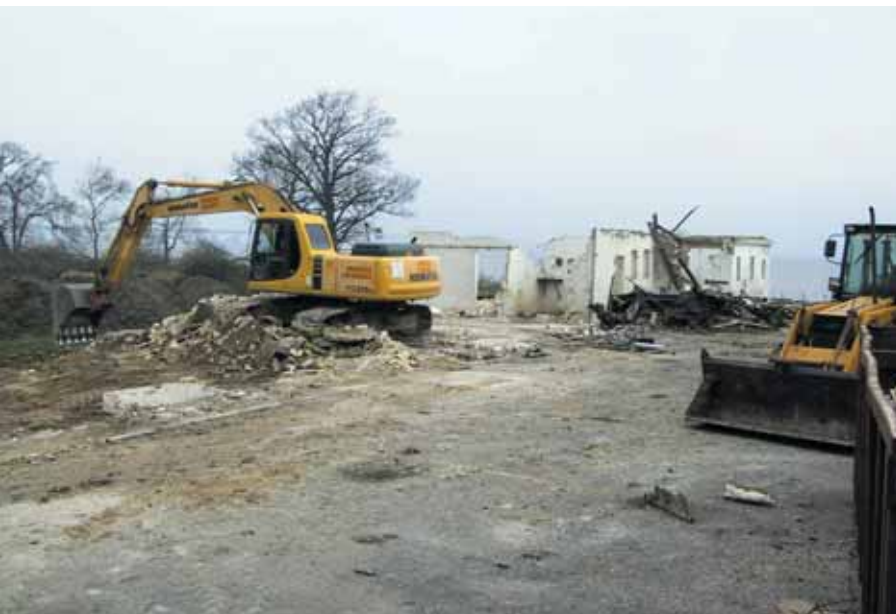
Driftsbygningerne rives ned. Hundreder års historie ender i containerne.
