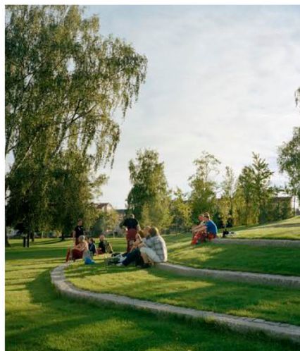
Stormflodssikring med landskabsdige, kote 2.50.
