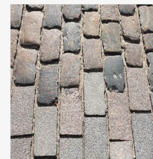
Gamle brosten fletter med skårne brosten der sikrer en tilgængelig belægning.
