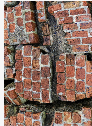
Gamle bygninger nedrives.
