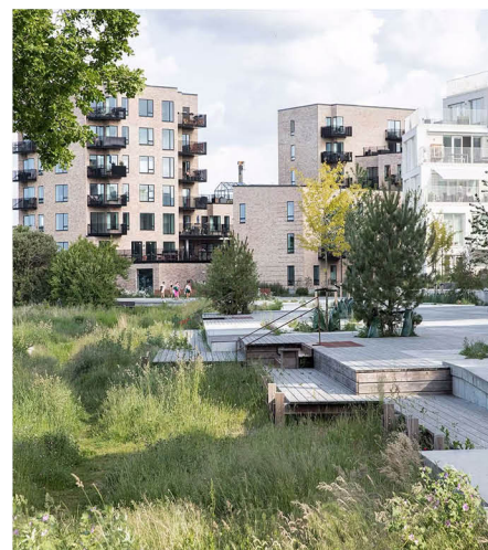
Stormflodssikring med bebyggelse på plint/terrænpude, kote 2.50.
