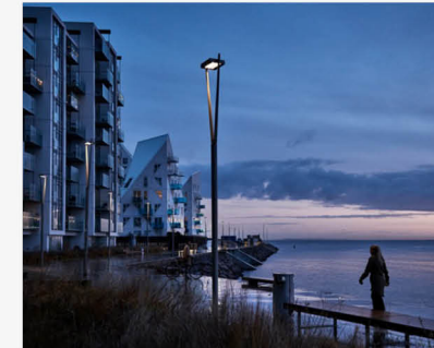
Belysningsmast med armatur langs promenade, Aarhus Ø.
