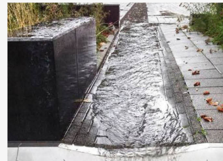
Åbne vandrender leder regnvandet på overfladen.
