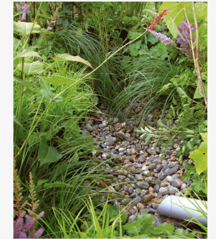
Regnbede med beplantning der kan tåle tørre og våde perioder.
