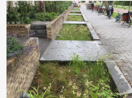
Vejbede til forsinkelse og rensning af regnvand.
