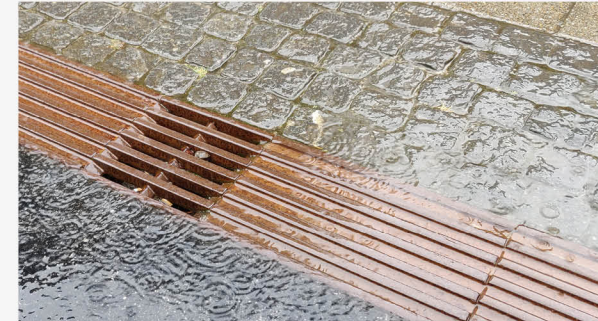
Punkttrist og åben linjeafvanding i ubehandlet støbejern.
