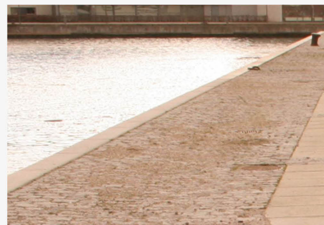
Belægninger med forskellige taktile overflader i relation havnekanter
